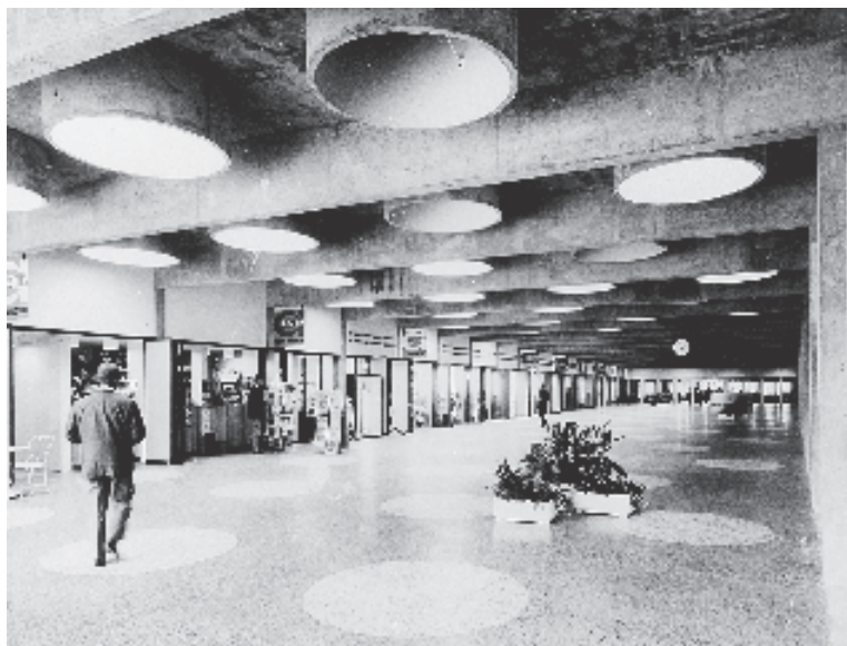
50. Entréhallen som den såg ut 1961. Ljusbrunnarna i taket motsvaras av golvmönstrets rundlar.
