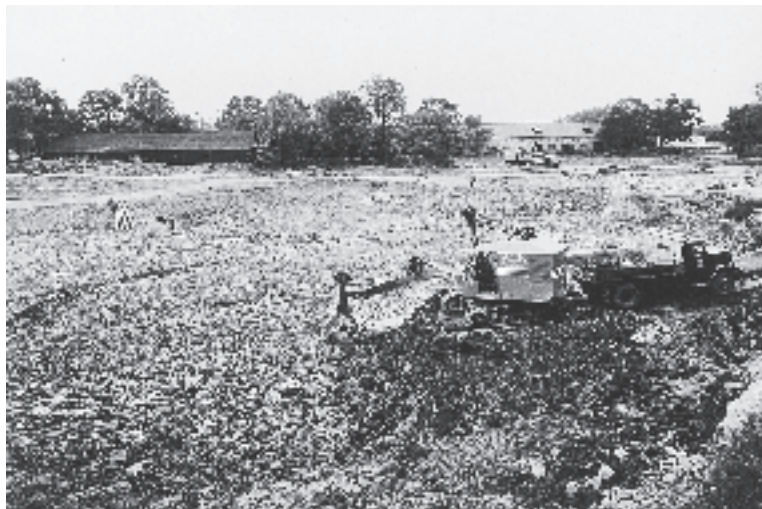
23. Kvarteret Förrådsbacken, tomten där radiohuset kom att byggas, när grundarbetena inletts 1958. Till höger syns Stora Stenskjulet, som blev personalrestaurang.
