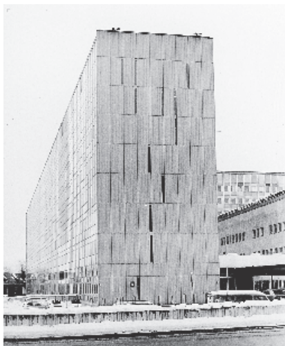
38. Radiohuset sett från Oxenstiernsgatan. Kontorshusets fasad är över 160 meter lång och gavlarna är artikulerade av långsmala fönster.
