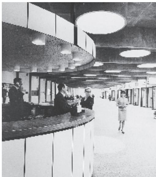
51. Entréhallen innan glasväggen sattes upp. Den runda receptionsdisken tog upp formen från ljusbrunnarna i taket och rundlarna i golvet.
