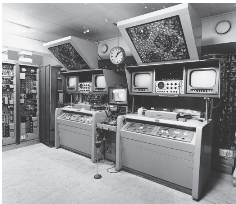
De två första Ampex-bandspelarna som installerades hos Sveriges Radio den 27 augusti 1959. Riktiga tungviktare. (Foto: SVT Bild)
